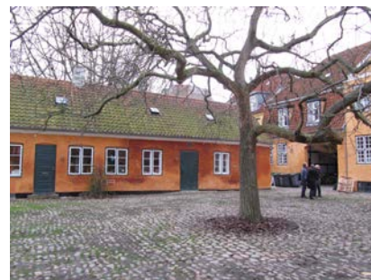
Den søndre gårdsplads med brosten og beplantning.
