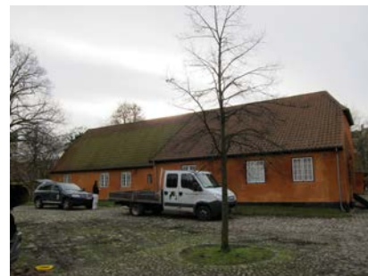
Bygning D med todelt facade mod nord.
